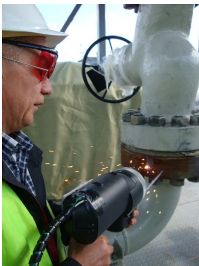
Рис.54. Практические примеры высокоэффективного применения лазерной очистки поверхности: очистка фланцевых соединений от ржавчины взамен пескоструйной технологии
