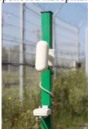
Рис.4.3. Линейный радиоволновой извещатель.
