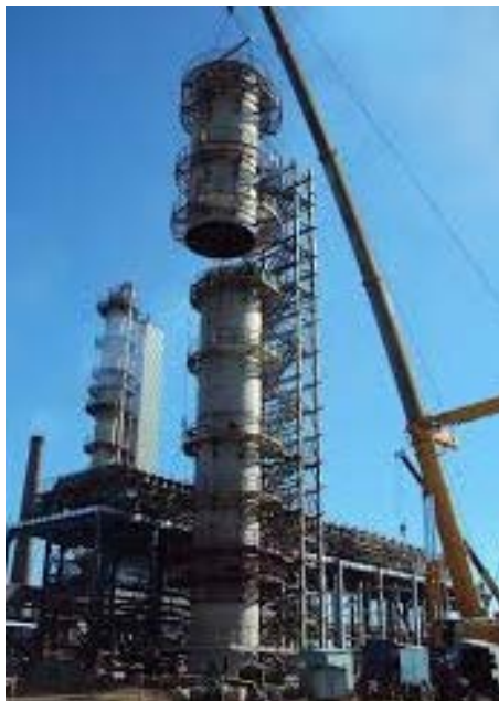
Рисунок 21 – Сборка колонны из отдельных секций
