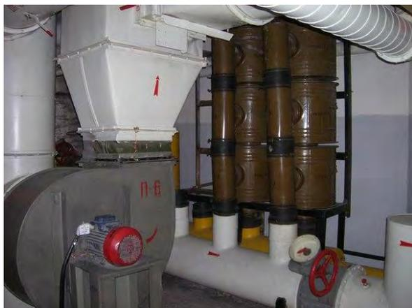
Рис. 4.1. Фильтровентиляционная камера
