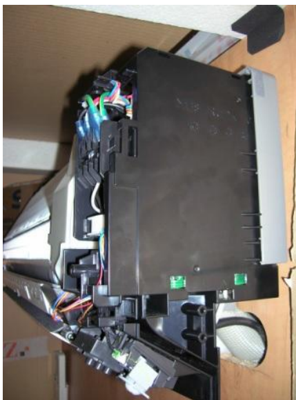
Рис. 3.2. Внутренний блок без крышки
