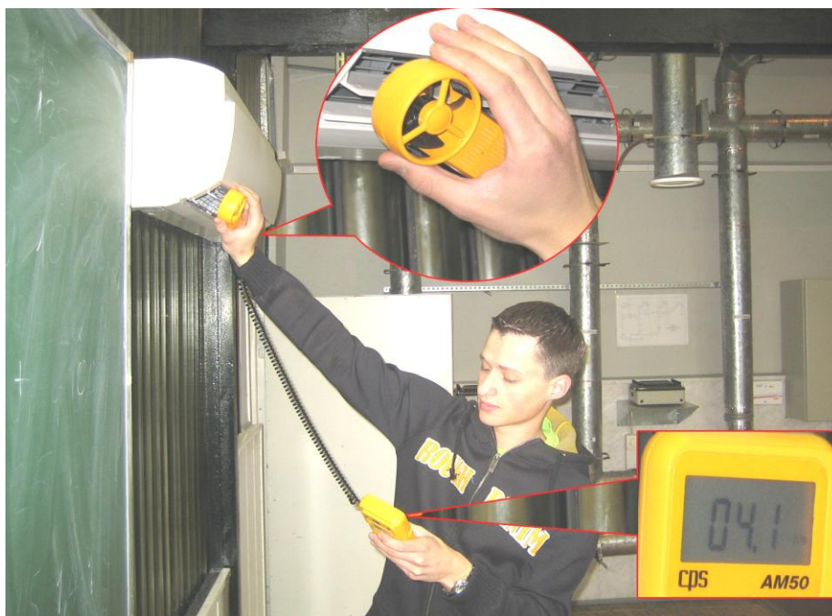
Рис. 1.4. Измерение скорости воздуха на выходе из внутреннего блока кондиционера
