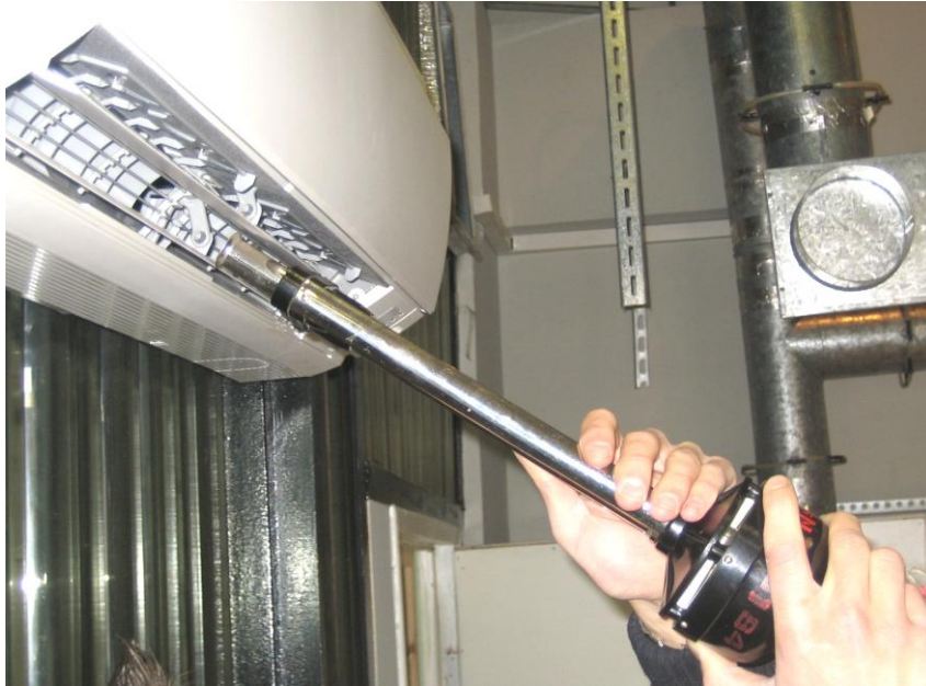
Рис. 1.3. Измерение температуры и влажности воздуха, выходящего из внутреннего блока кондиционера
