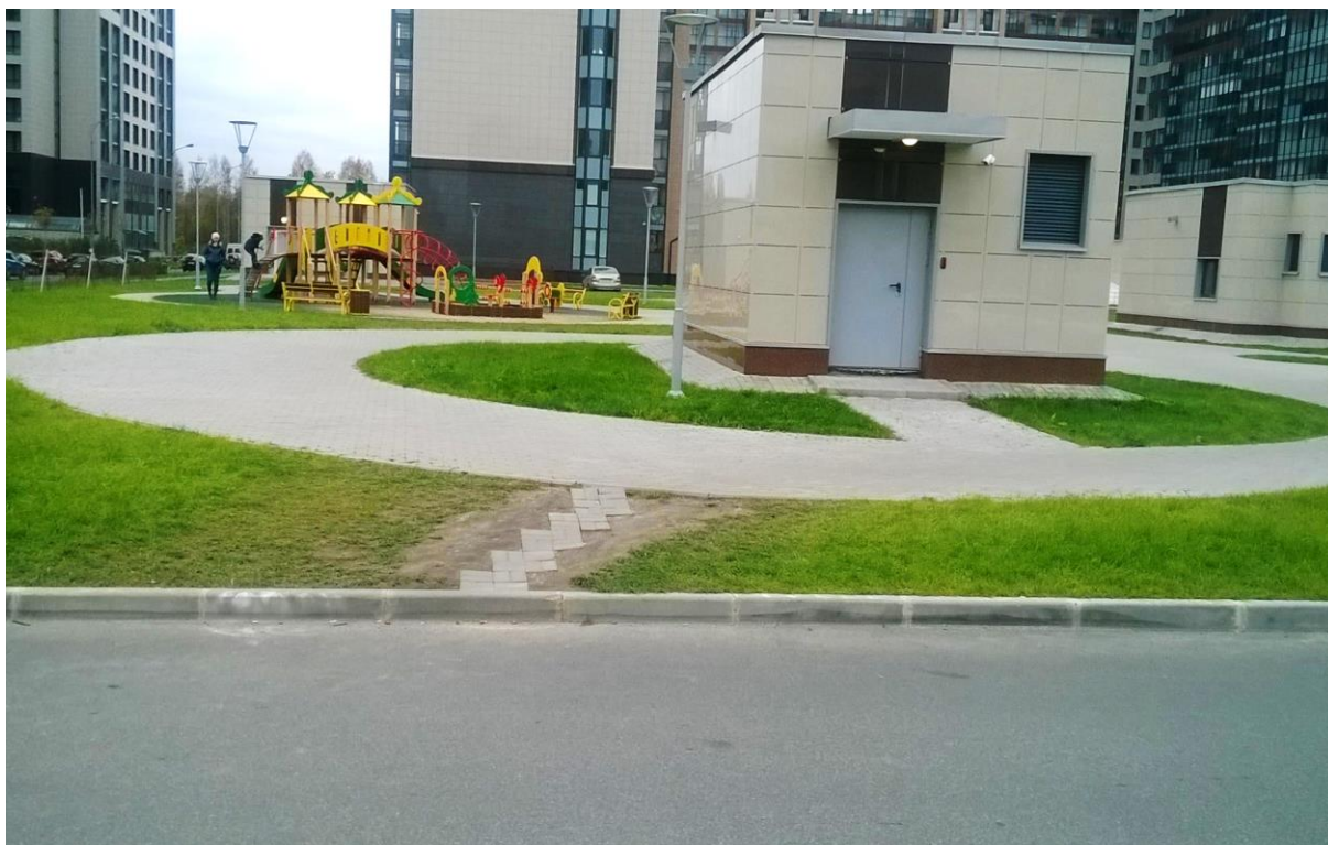
Рисунок 27. Круговая дорожка вокруг входа в подземный паркинг нигде не примыкает к идущему буквально в двух метрах проезду. Местным жителям пришлось заняться благоустройством самостоятельно
