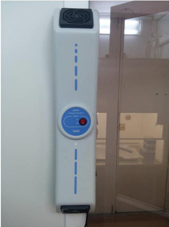
Рисунок 3. Настенный рециркулятор воздуха. Обеспечивает дезинфекцию воздуха с помощью УФ-ламп, размещенных внутри. Рециркулятор необходимо включать раз в неделю во время полного облучения бокса
