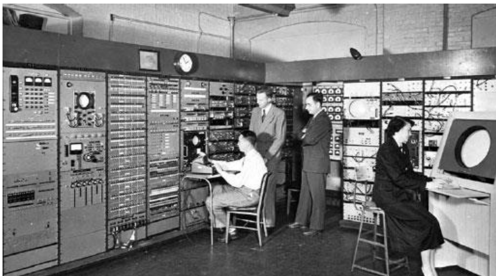
Рисунок 2.1 – Фрагмент компьютера «Whirlwind»
