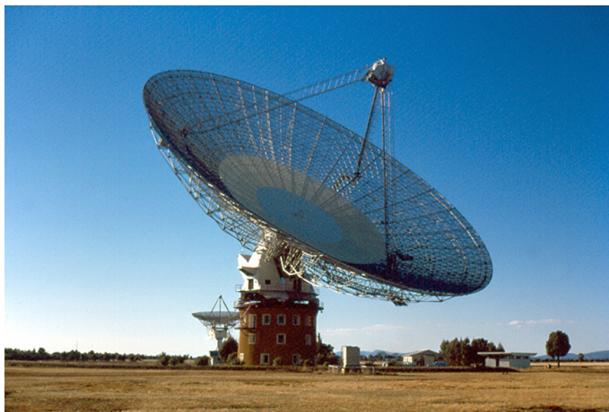
Рис. 5.13: Зеркало радиотелескопа в виде сетки из проводов: на частотах рабочего диапазона длина радиоволн составляет порядка дециметра, и сетка из проводов ведет себя как идеальный проводник и позволяет сформировать узкий луч телескопа, при этом такая конструкция гораздо легче и более устойчива к ветровым нагрузкам, чем зеркало из сплошного листа металла. Источник: apo.rf/материалы/радиотелескопы
