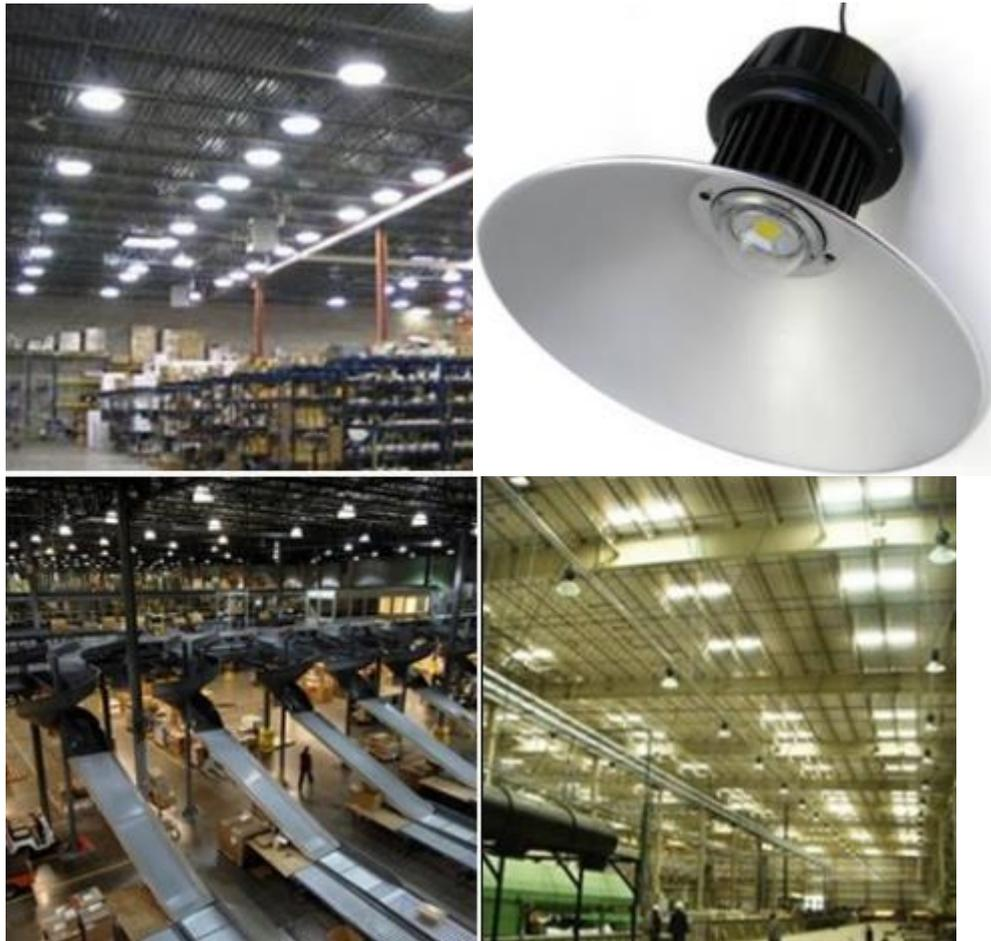
Рис. 55. Светильники для высоких пролётов (*high-bay light fixture*).
