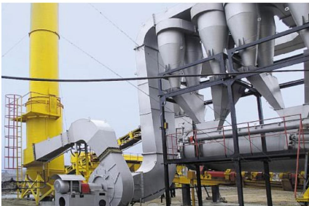
Рис. 3.7. Батарея циклонов
