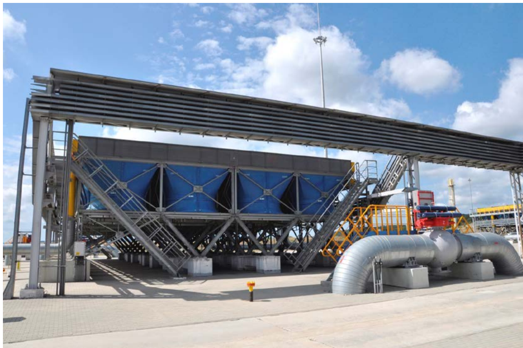
Рисунок 4 – Аппараты воздушного охлаждения КС «Казачья» ООО «Газпром трансгаз Краснодар» [10]
