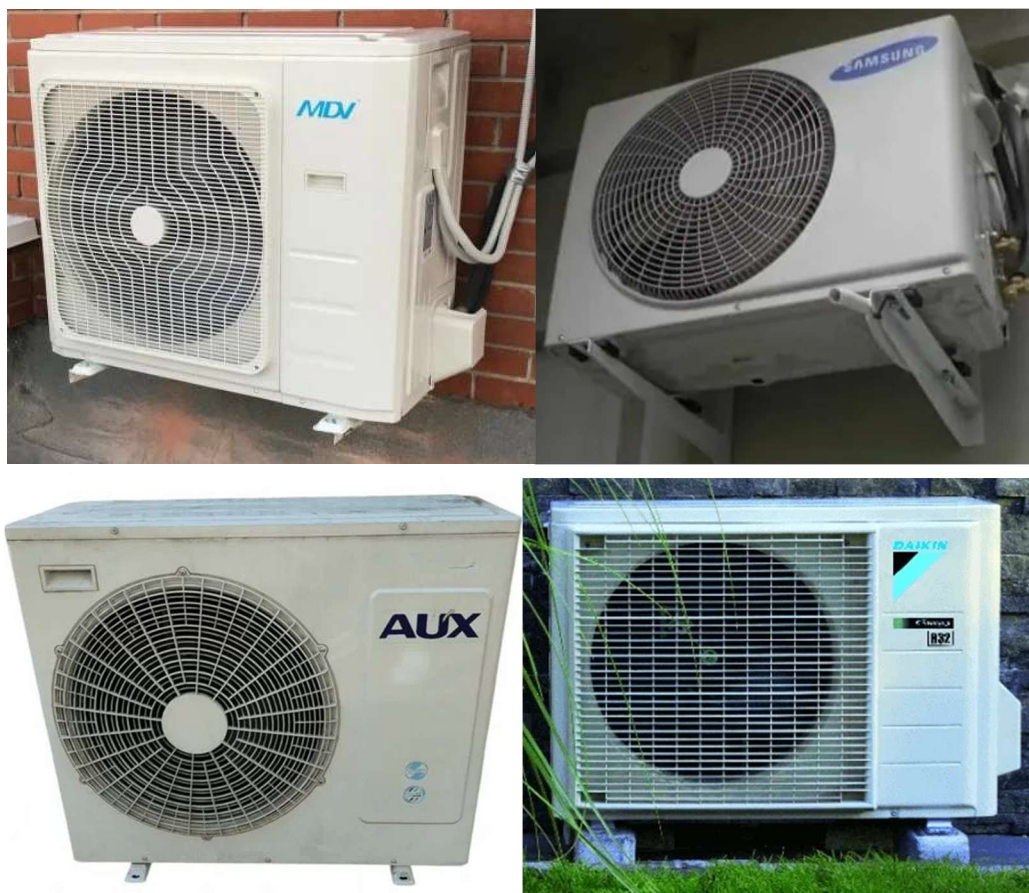
Рисунок 41 – Примеры внешних блоков кондиционеров.
